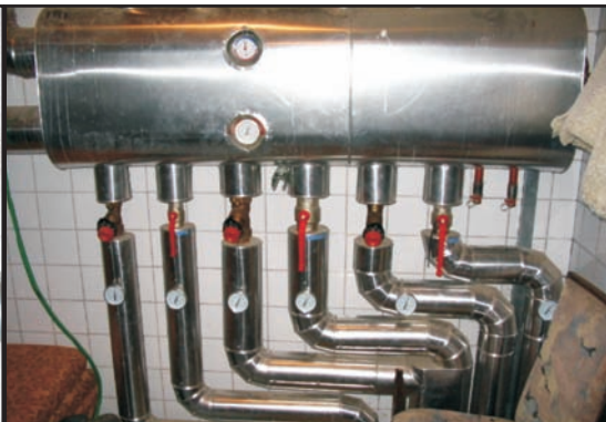
Toplotno razdelilna postaja za napajanje posameznih objektov turistične kmetije
